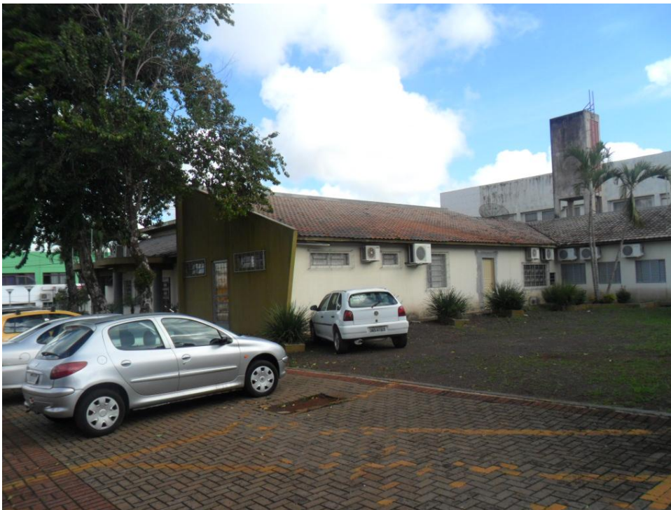
FOTO 05- ÁREA EXTERNA: LOCAL À SER EXECUTADO O ESTACIONAMENTO EM PAVER E GRADIL COM PORTÃO ELETRÔNICO.
