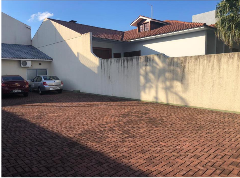
2 Módulos de Coberturas no Lado Direito
