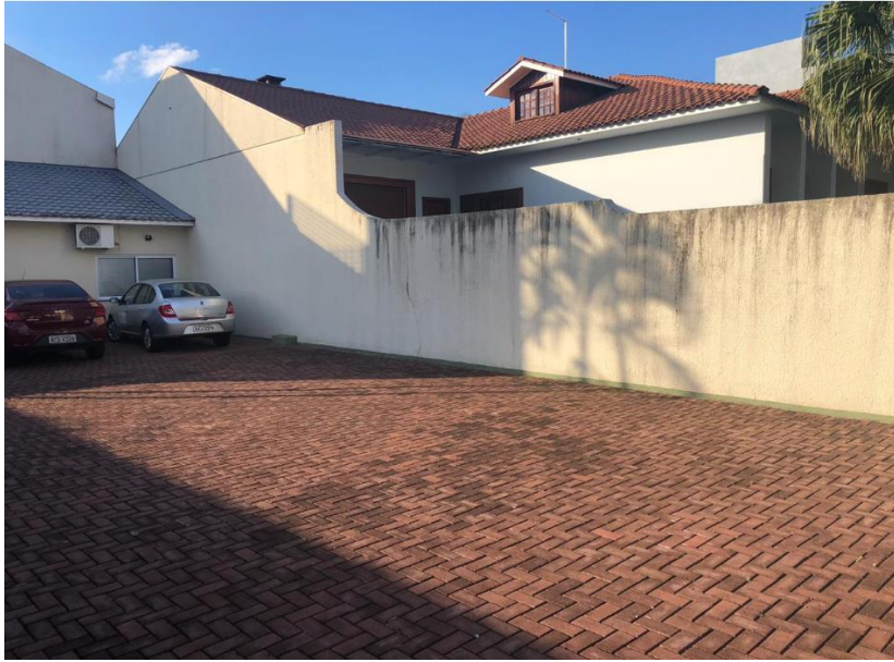
2 Módulos de Coberturas no Lado Direito
