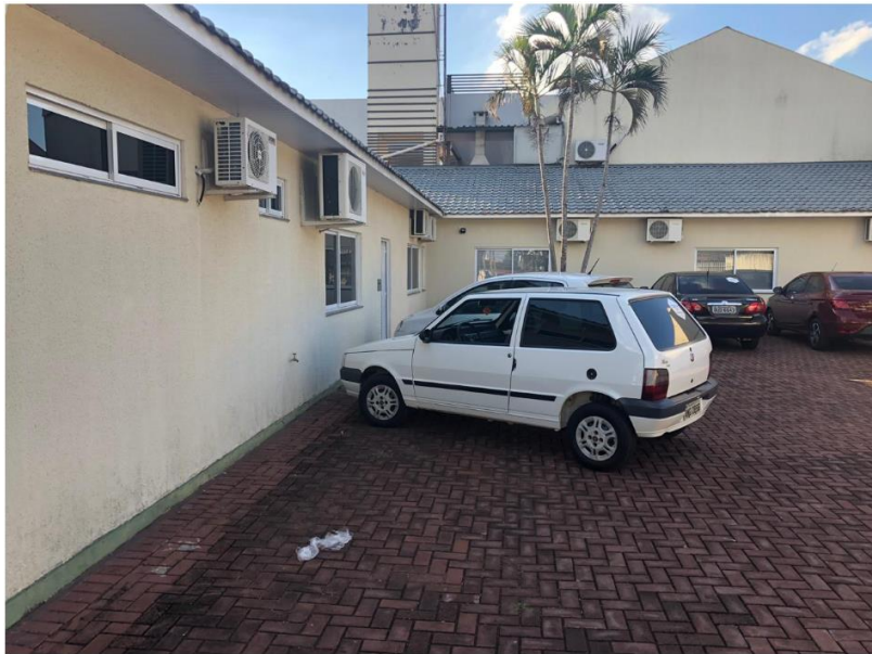
2 Módulos de Coberturas no Lado Esquerdo
