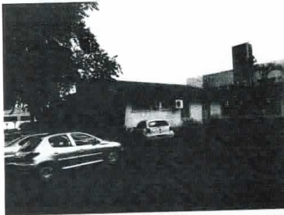
FOTO 05- ÁREA EXTERNA: LOCAL À SER EXECUTADO O ESTACIONAMENTO EM PAVER E GRADIL COM PORTÃO ELETRÔNICO.
