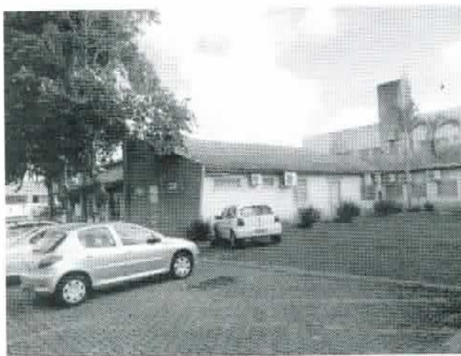
FOTO 05- ÁREA EXTERNA: LOCAL À SER EXECUTADO O ESTACIONAMENTO EM PAVER E GRADIL COM PORTÃO ELETRÔNICO.
