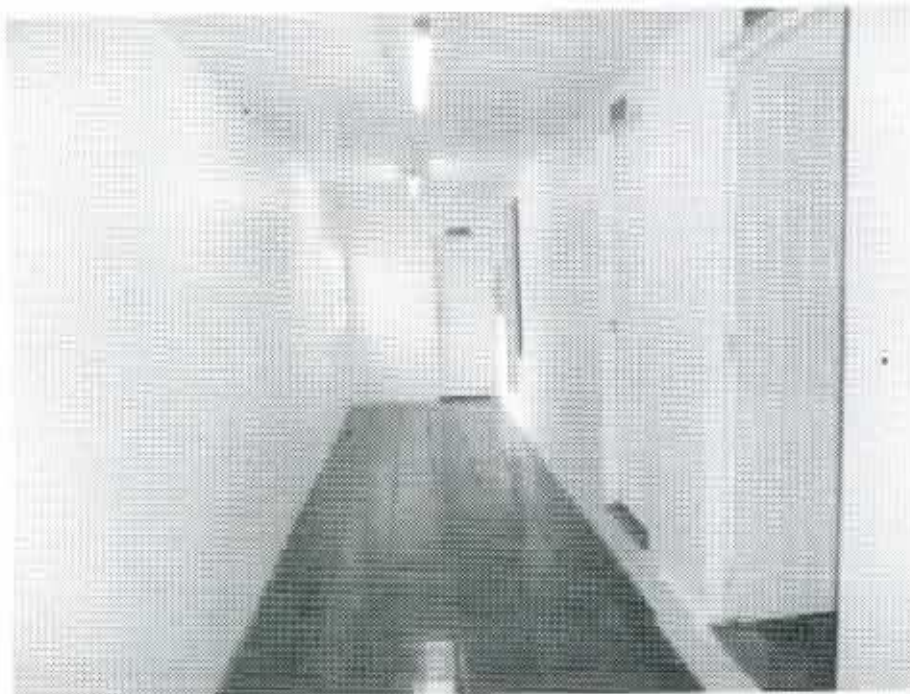
FOTO 06- ÁREA INTERNA: SANITÁRIO AOS FUNDOS À REFORMAR E PISO A SUBSTITUIR, FORRO EM BOAS CONDIÇÕES SOMENTE NÁ ÁREA DE CIRCULAÇÃO AS SALAS NOVAS
